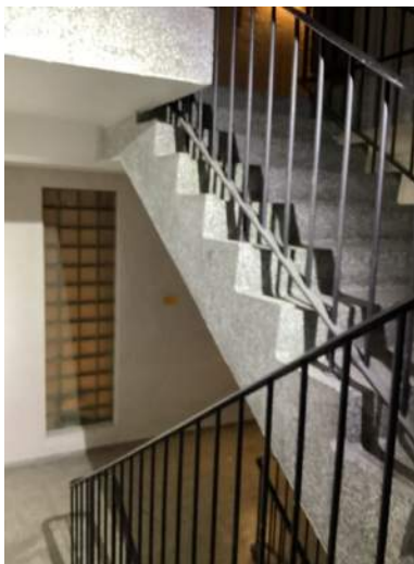
Repostrapp Bygg A
