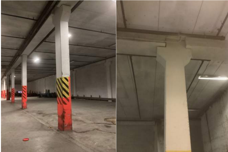
Søyler, bjelker og dekker i den øvre lavlagerdelen
