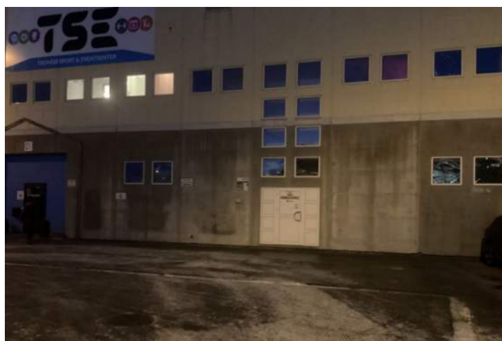
Betongelementer på sørsiden av bygg E
