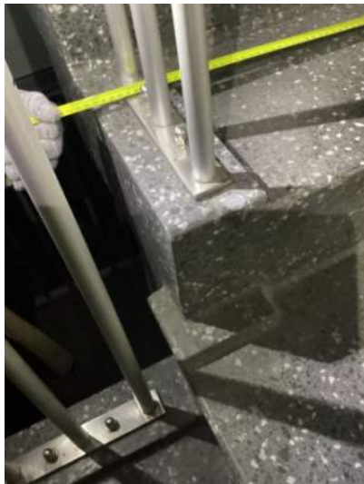
Detalj fra trapp i bygg C
