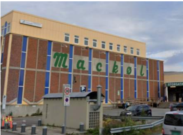
Eksisterende nordfasade, Mack Øst
