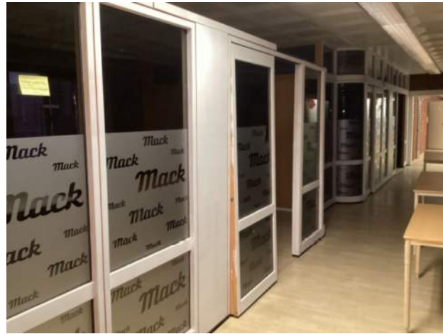
Systemveggene i malt tre/platemateriale er mer slitt
