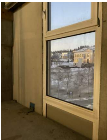
Avtagbar fasadeelement sett fra innsiden
