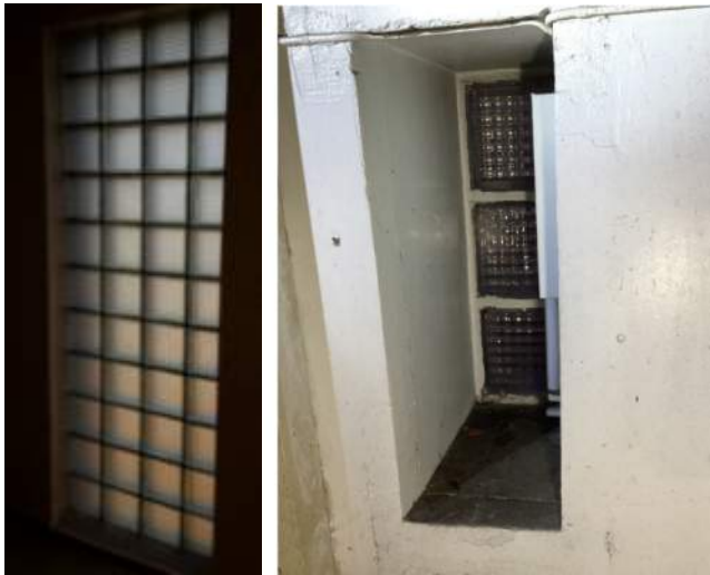
Eksisterende glassbyggestein i Mack øst
