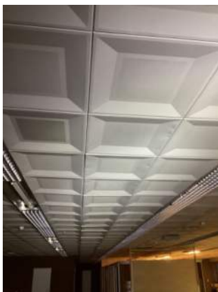
Systemhimling av lydabsorberende plater, på bilde til høyre vises baksiden av disse
