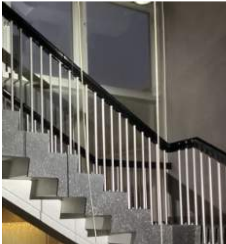
Eksisterende rekkverk i bygningsdel D, Mack øst
