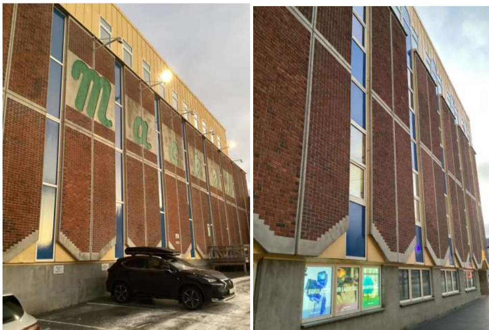
Avtagbare fasadeelement på bygg D, sør og øst fasaden
