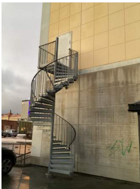
Rømningstrapp sør-øst bygg E
