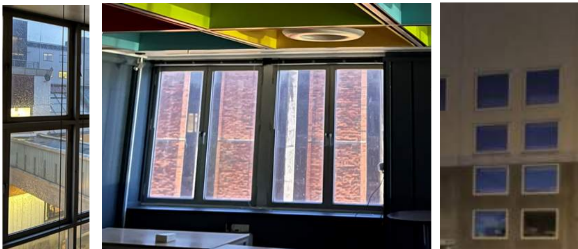
Eksisterende vinduer i bygget
