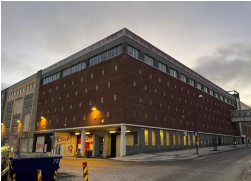
Bygg C sett fra nord-øst. Man skimter broa over til Mack vest til høyre i bildet
