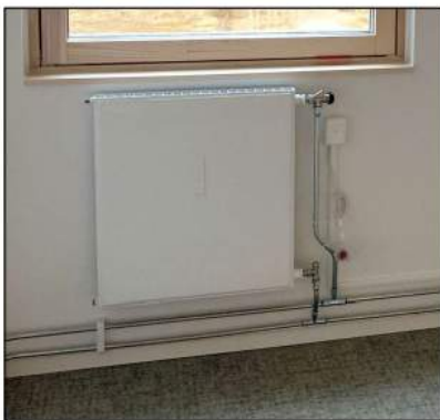
Ferdig montert etter bearbeiding. Foto: Randi Lunke
