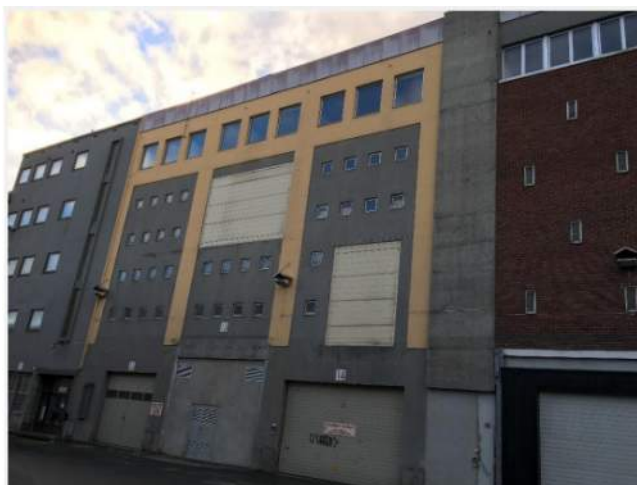
Bygg B sett fra nord
