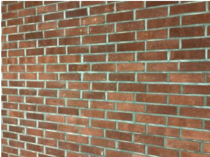
Innvendig mursteinsvegg bygg C, 4 etg
