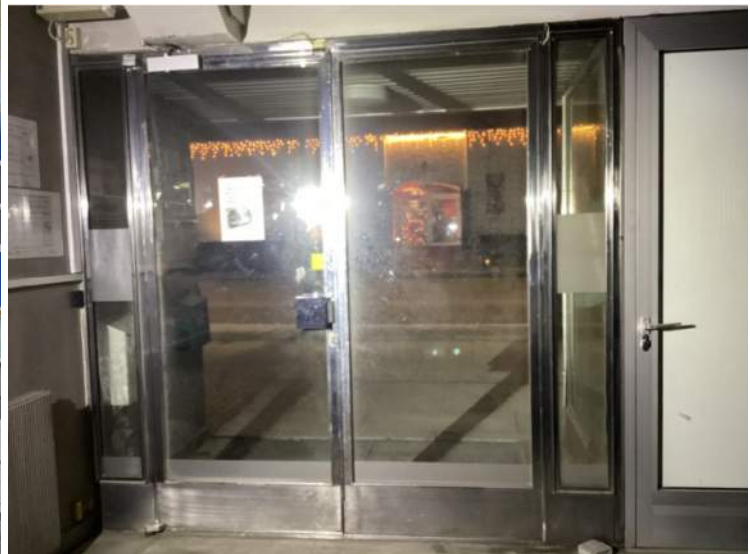
Inngangsdøren sett fra innsiden
