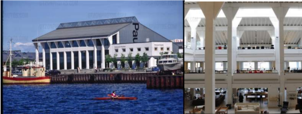
Referanseprosjekt av Jørn Utzon der prefab-elementer er brukt o gjort synlige i bygget. "Paustians Furniture Exhibition house", København.
