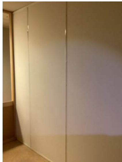
Systemskillevegger mellom kontorene i ok stand
