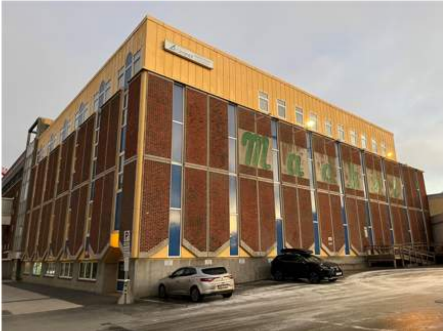
Bygg D sett fra sør-vest
